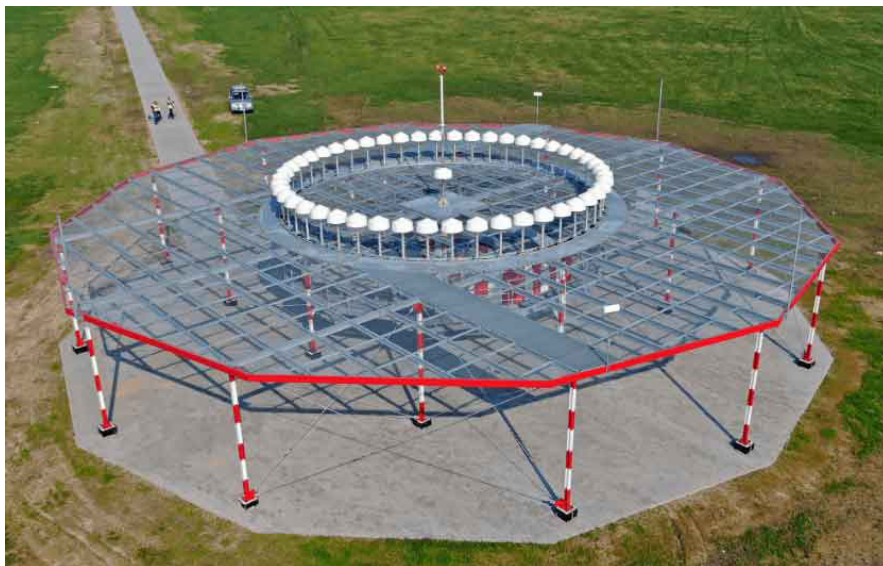
Ryc. 6. Nziemna radiolatarnia DVOR/DME, źródło: ze zbiorów autora
