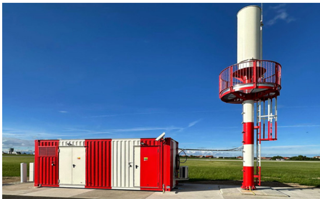
Fot.2. Wojskowy system radionawigacyjny TACAN; źródło: ze zbiorów autora
